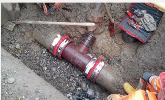
Późniejszy montaż odgałęzienia w istniejącym rurociągu kamionkowym
