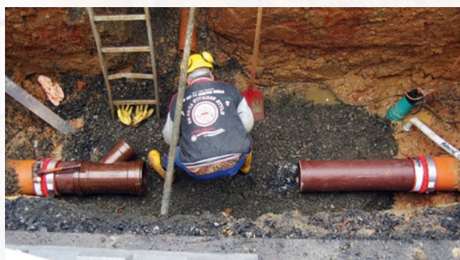
Naprawa uszkodzonych przewodów
