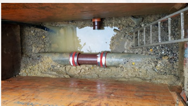
Późniejszy montaż odgałęzienia w istniejącym rurociągu kamionkowym
